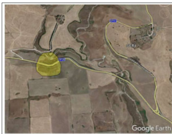
Foto aerea dell'area della SP 38 interessata da cedimenti della sede stradale (area campita in giallo)
