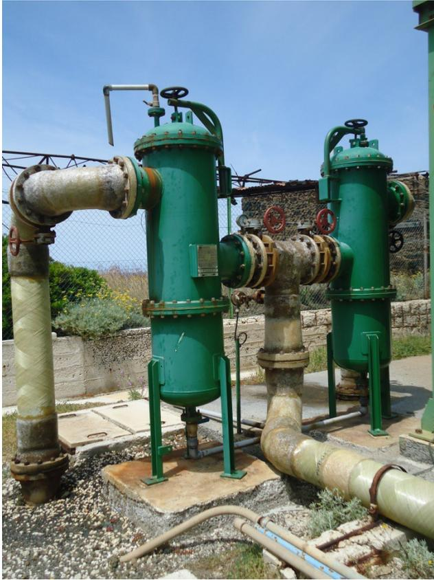
Figura 8 Filtri a cartuccia dell'impianto MED-MVC di contrada Sataria a Pantelleria.
