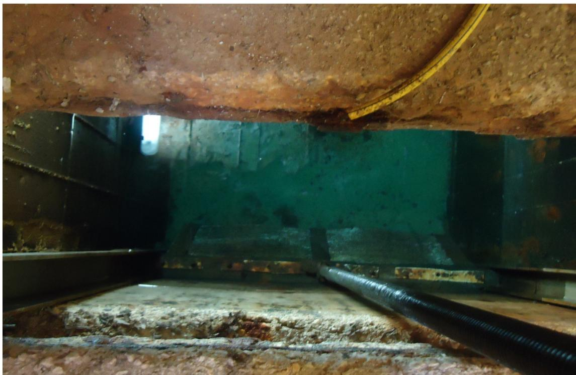
Figura 7. Unità di grigliatura presente nell'opera di presa a mare dell'impianto MED-MVC di Contrada Sataria a Pantelleria.
