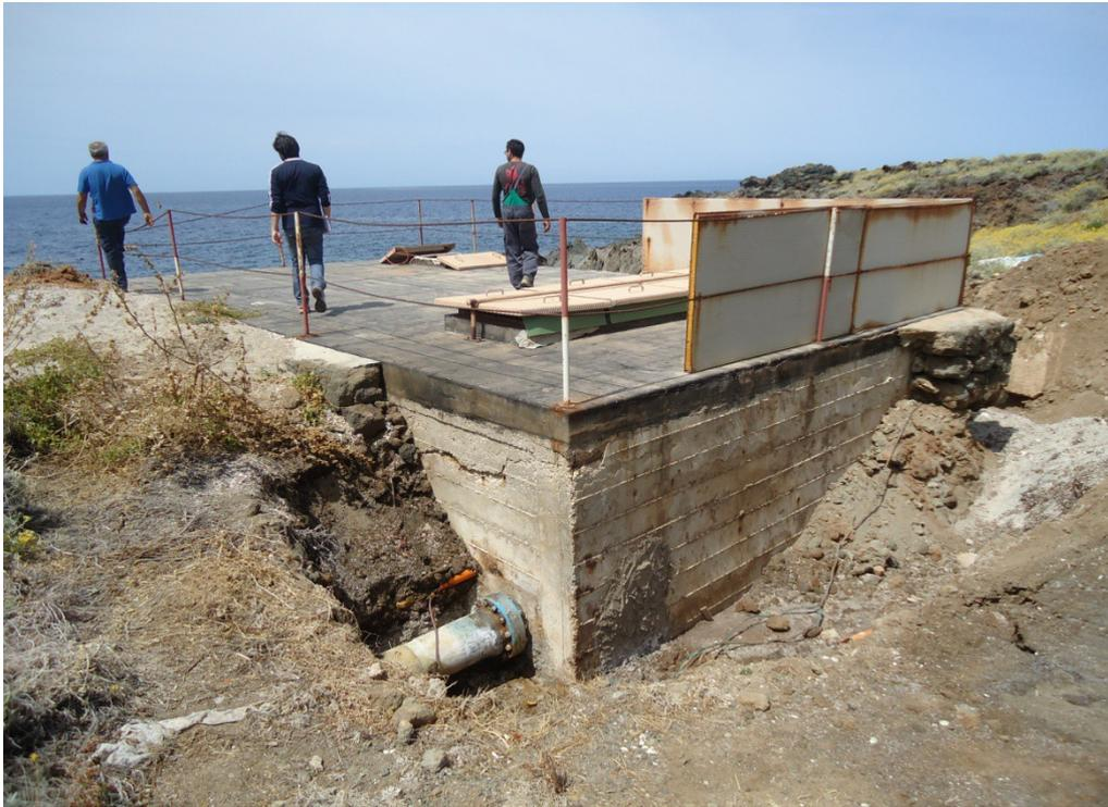
Figura 6 Opera di presa a mare dell'impianto MED-MVC di contrada Sataria a Pantelleria.
