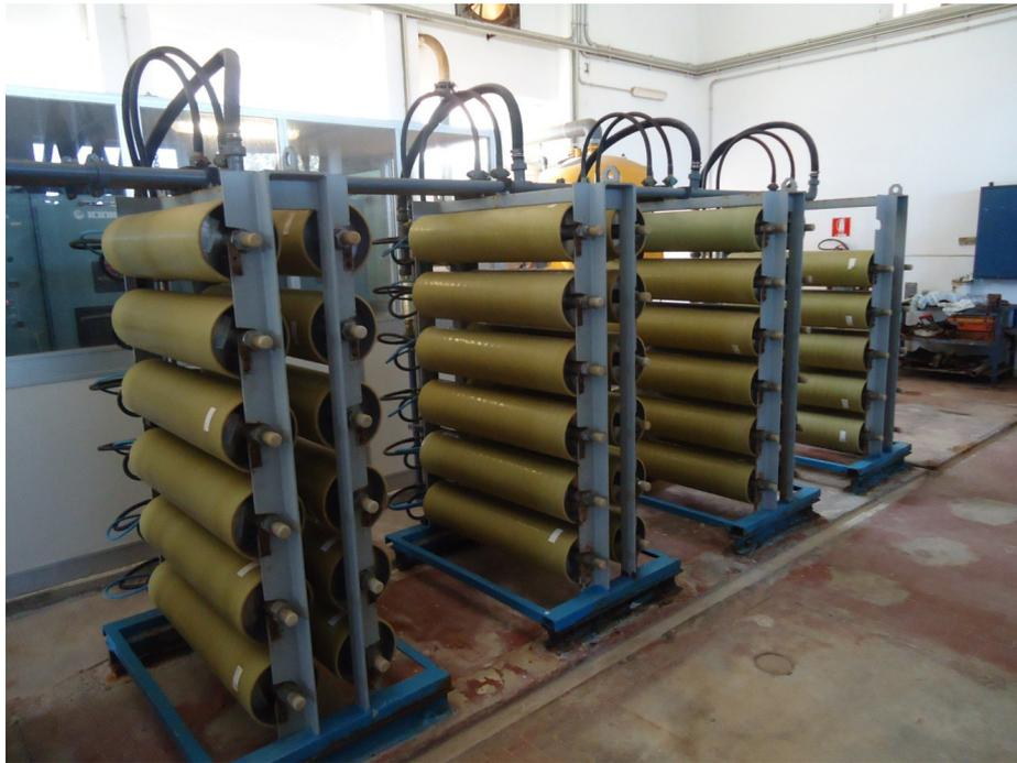
Figura 3 Vista dell'unità ad osmosi inversa (impianto di Pantelleria C.da Maggiuluedi).
