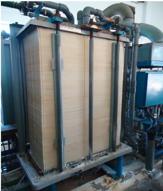
Figura 2 Interno di un modulo a membrana dell'unità EDR (impianto di Pantelleria C.da Maggiuluedi).
