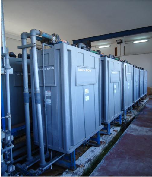
Figura 1 Vista di una delle due linee costituenti l'unità EDR (impianto di Pantelleria C.da Maggiuluedi).
