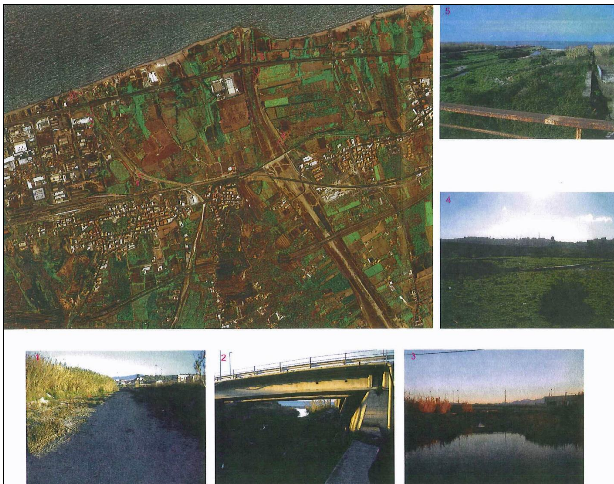
Figura 5: Documentazione fotografica relativa tratti terminali dei Torrenti Muto e Niceto
