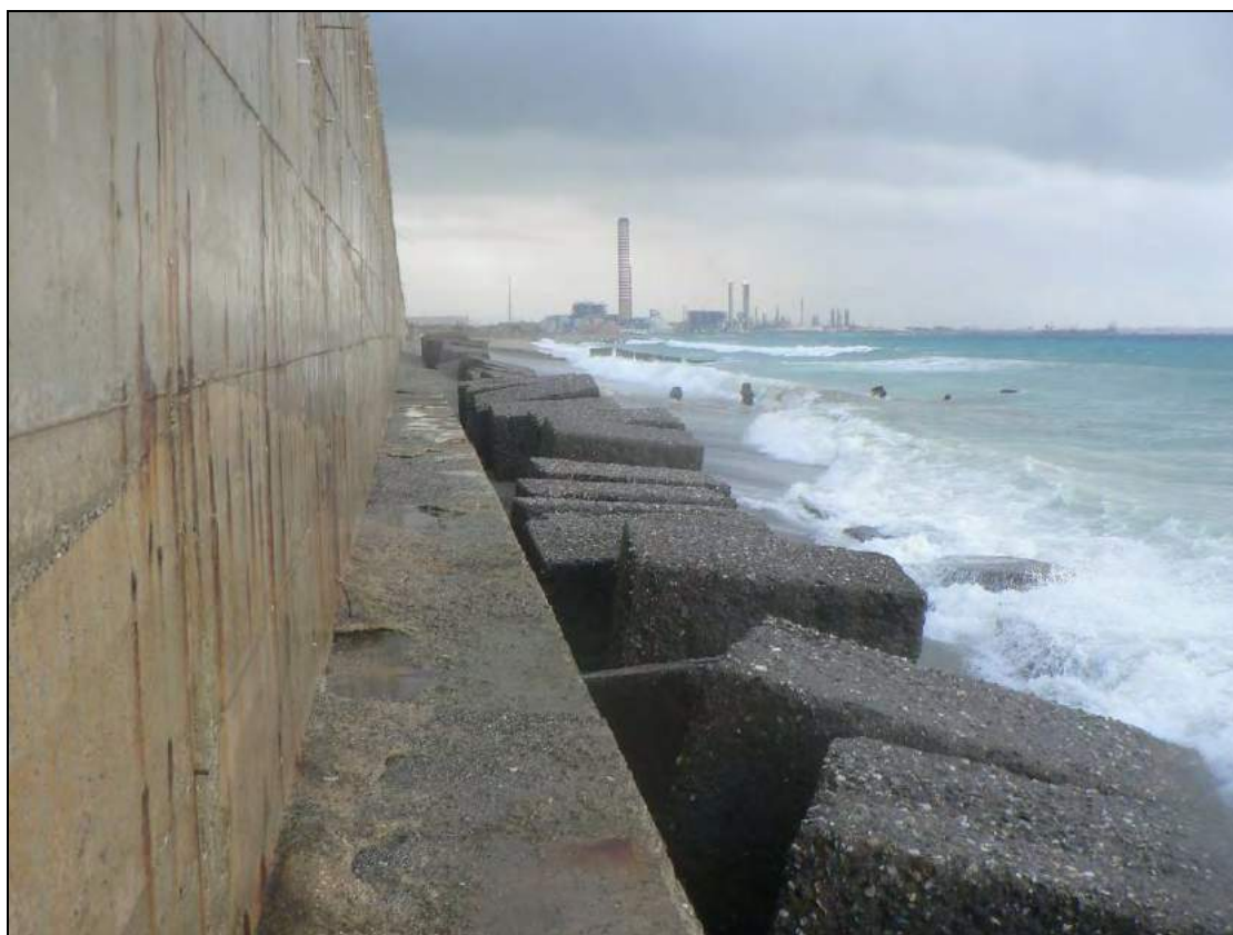
Figura 11: Muro perimetrale del depuratore consortile (Foto 11)
