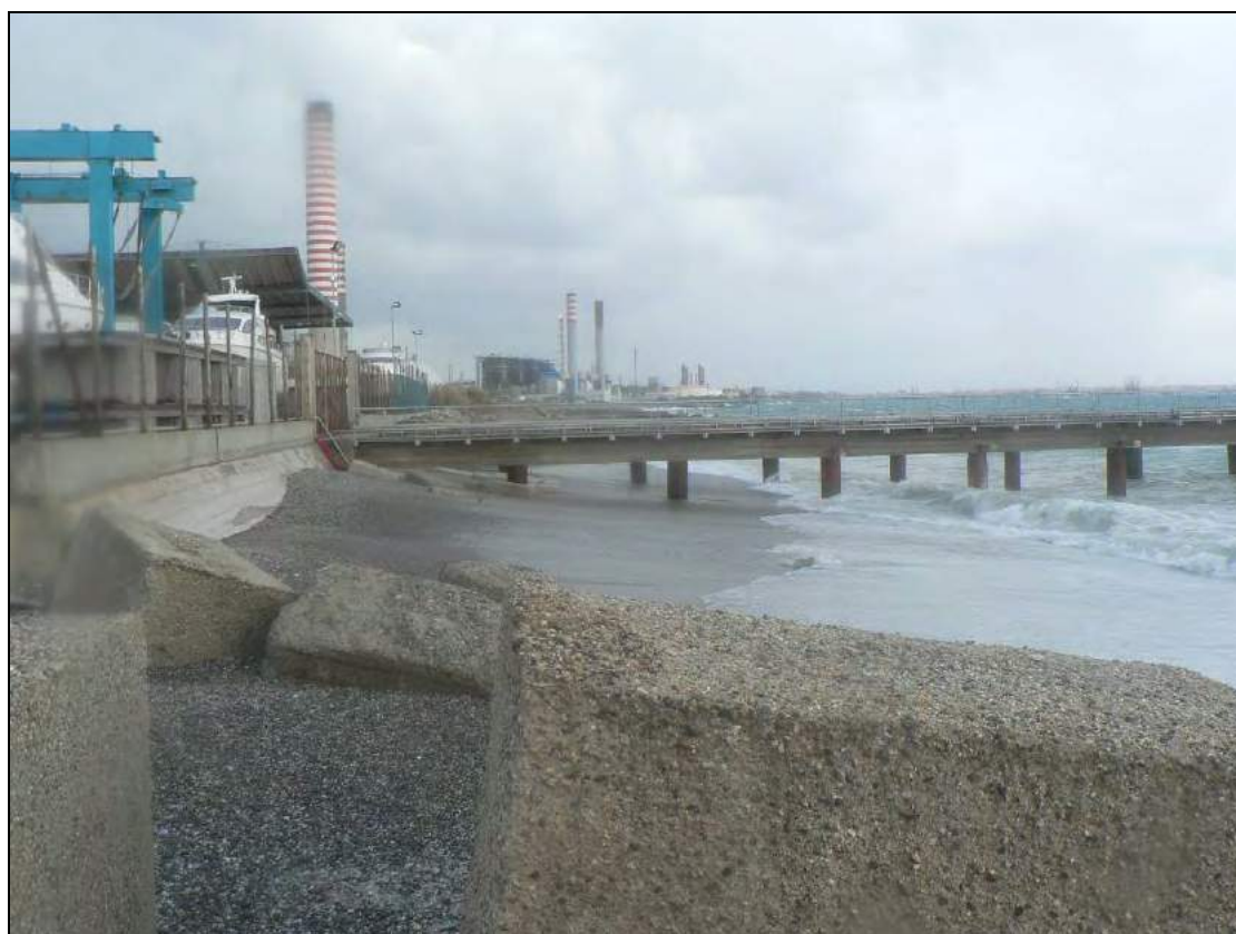
Figura 16: Cantiere di rimessaggio (Foto 16)
