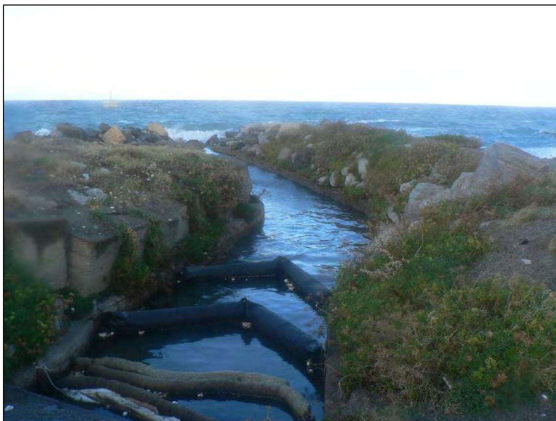
Figura 20: Canale di scarico della centrale Enel (Foto 20)
