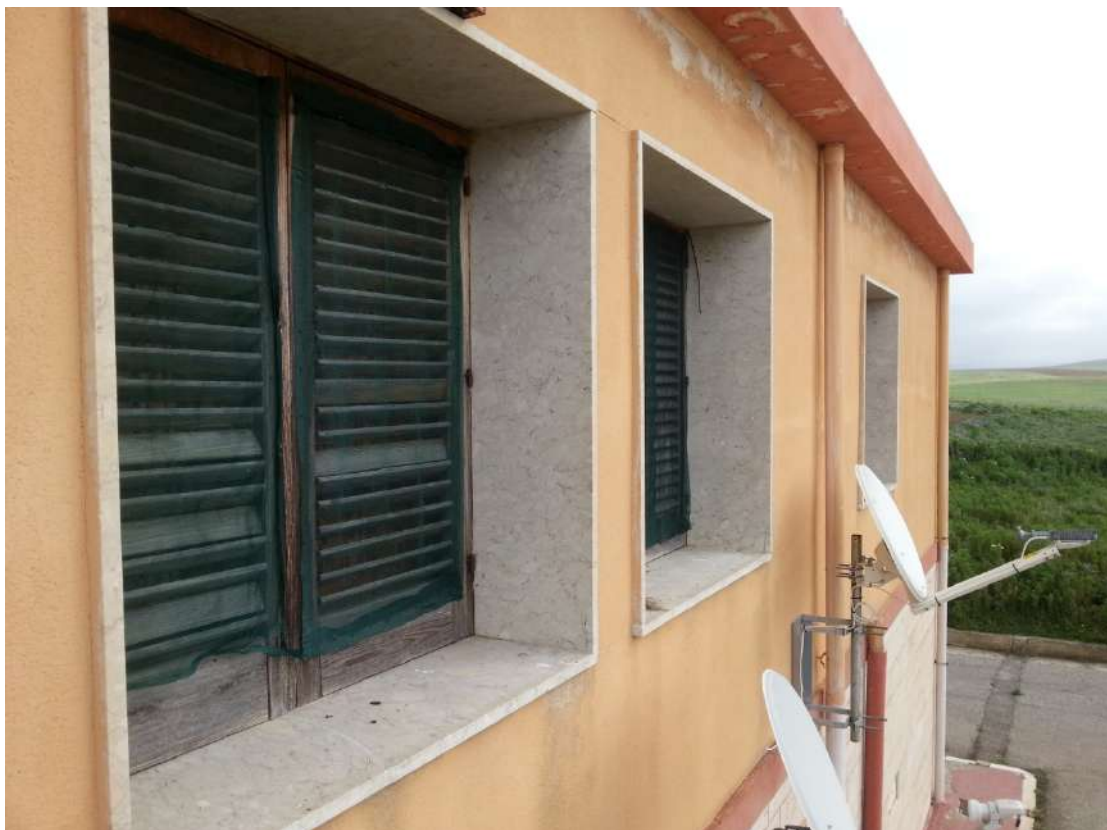
Foto 16 – Particolare infissi casa di guardia
