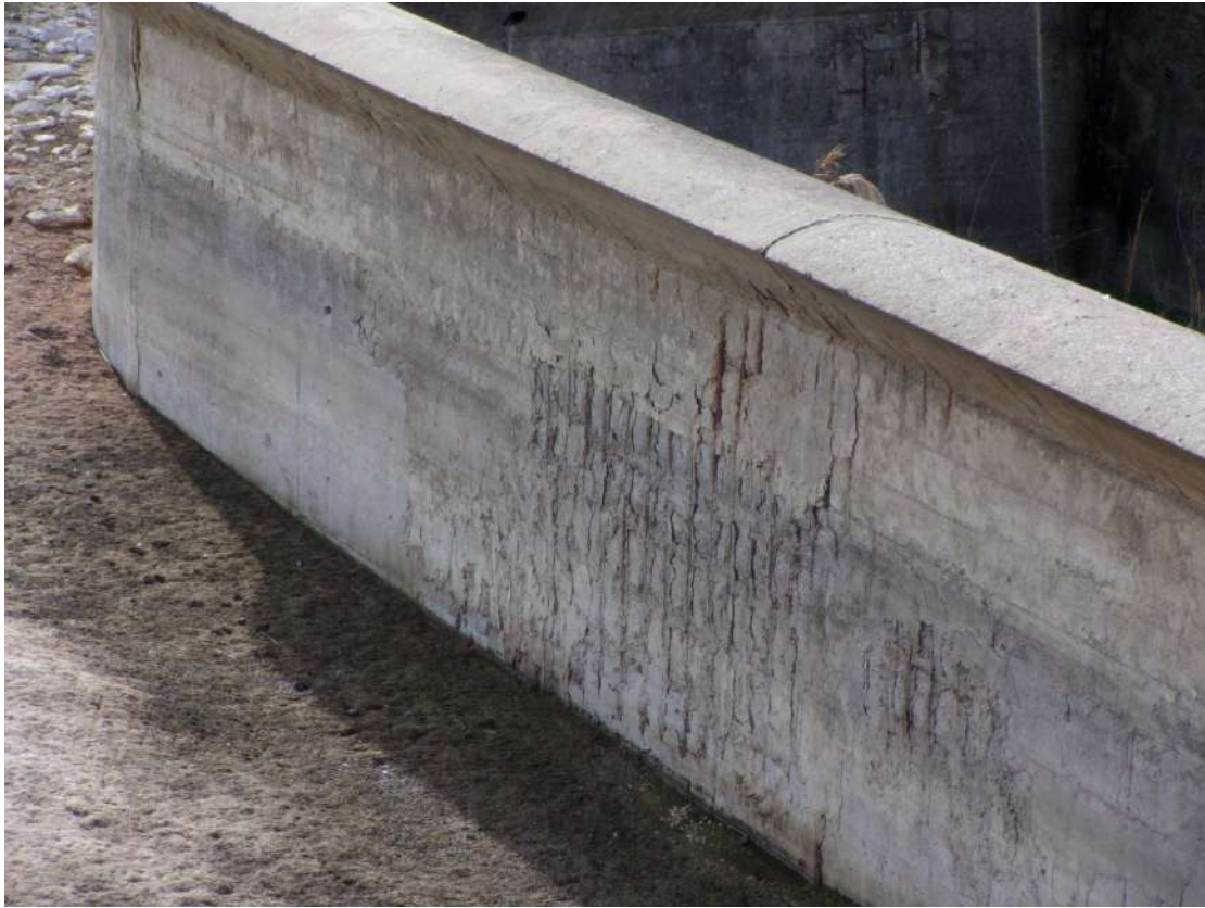
Foto 5 – Scarico di superficie – particolare esterno dello sfioratore
