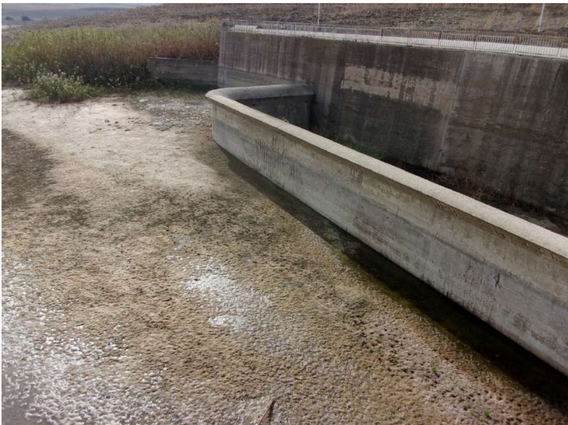
Foto 6 – Scarico di superficie – Sfiatore
