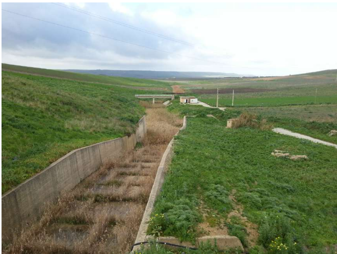
Foto 10 – Canale di scarico e vasca di dissipazione
