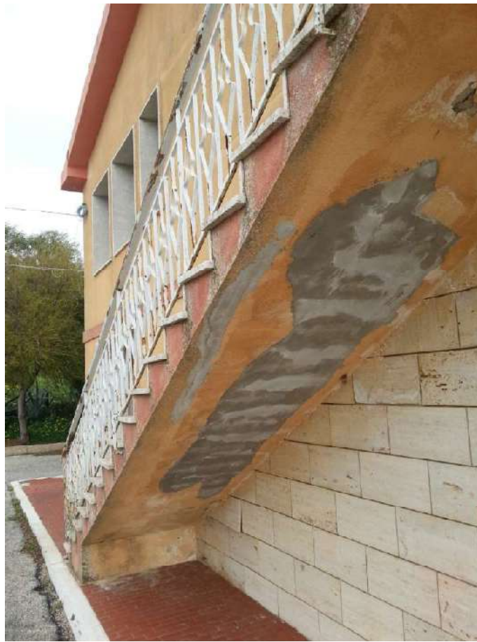
Foto 15 – Particolare estradosso scala di accesso al piano primo
