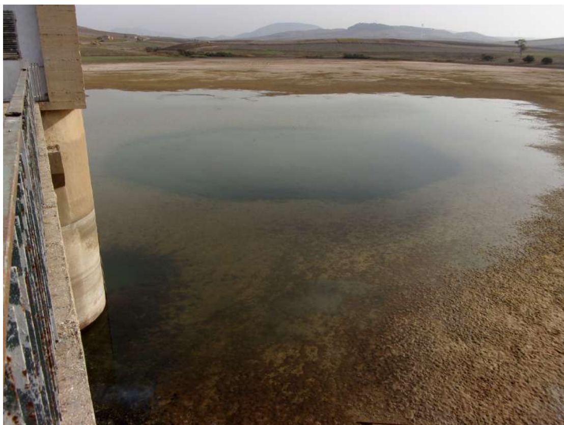
Foto 1 – Area imbocco scarico di fondo
