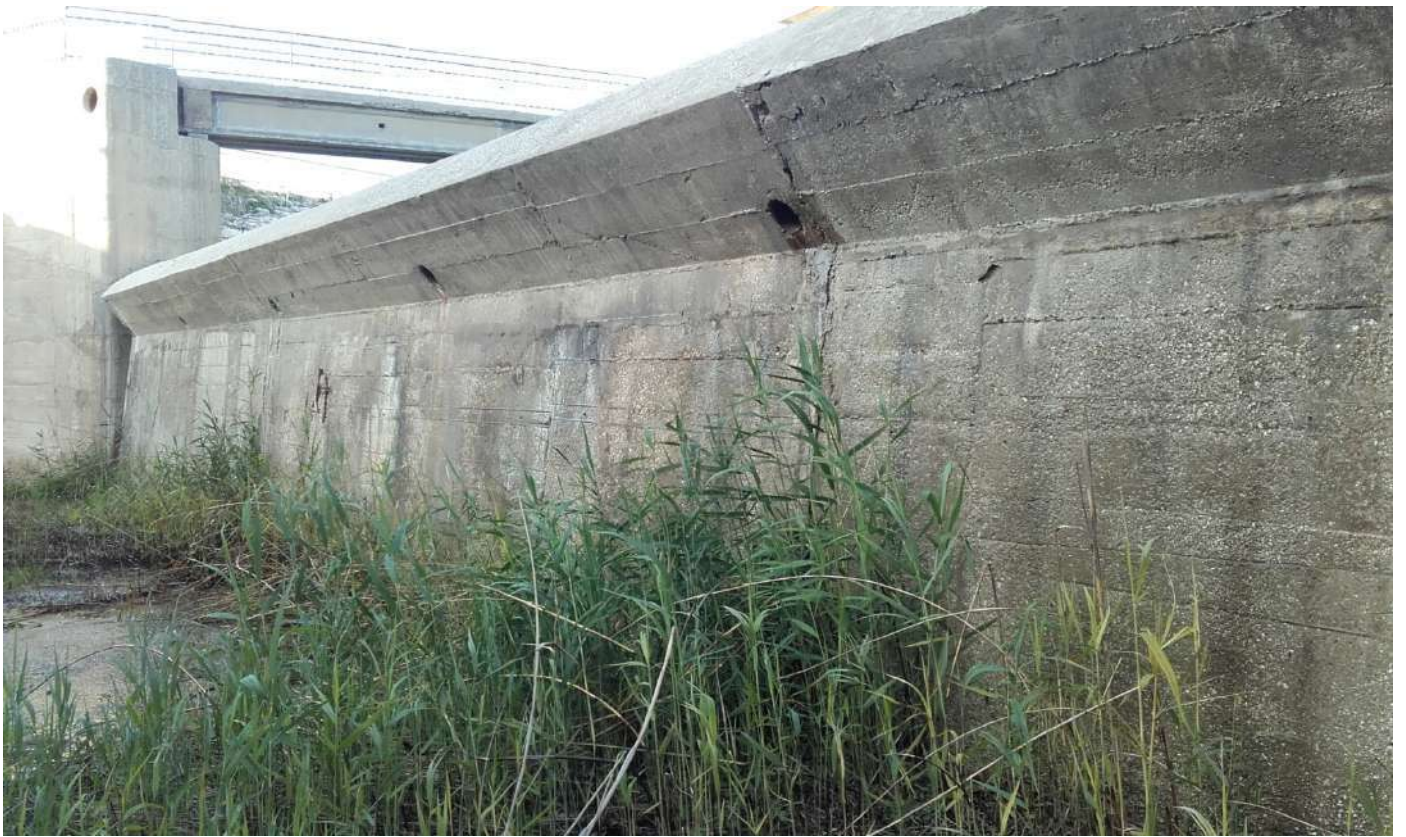
Foto7 – Scarico di superficie – particolare interno dello sfioratore
