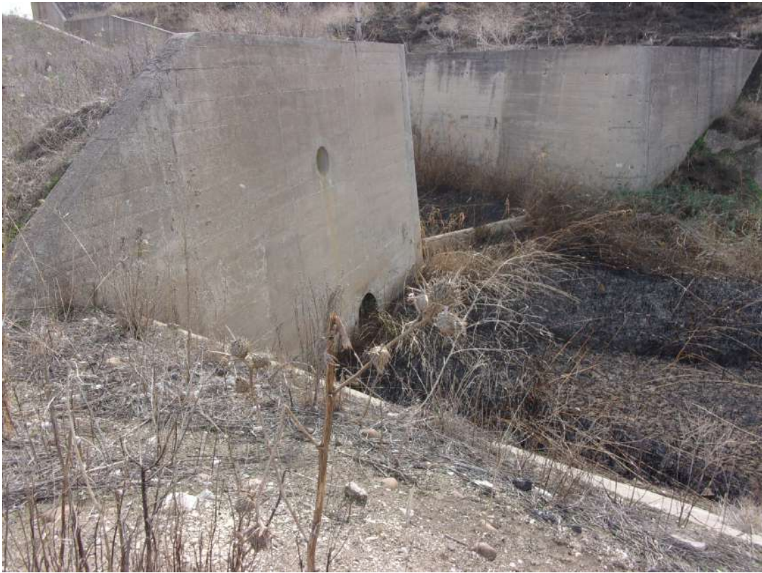
Foto 9 – Punto di sbocco dello scarico di fondo
