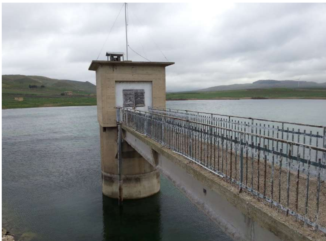
Foto 2 – Torre manovra scarico di fondo
