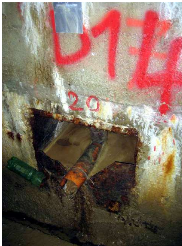
FOTO 4 - Cunicolo perimetrale - D14 (canna drenante 20) mezzeria a quota 101,50
