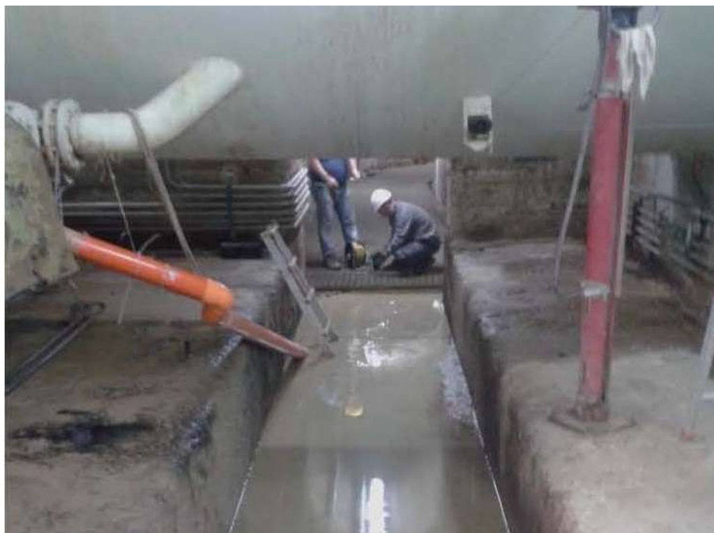
FOTO 6 – Cunicolo in fondazione – camera di manovra scarichi sussidiari a quota 89,70
