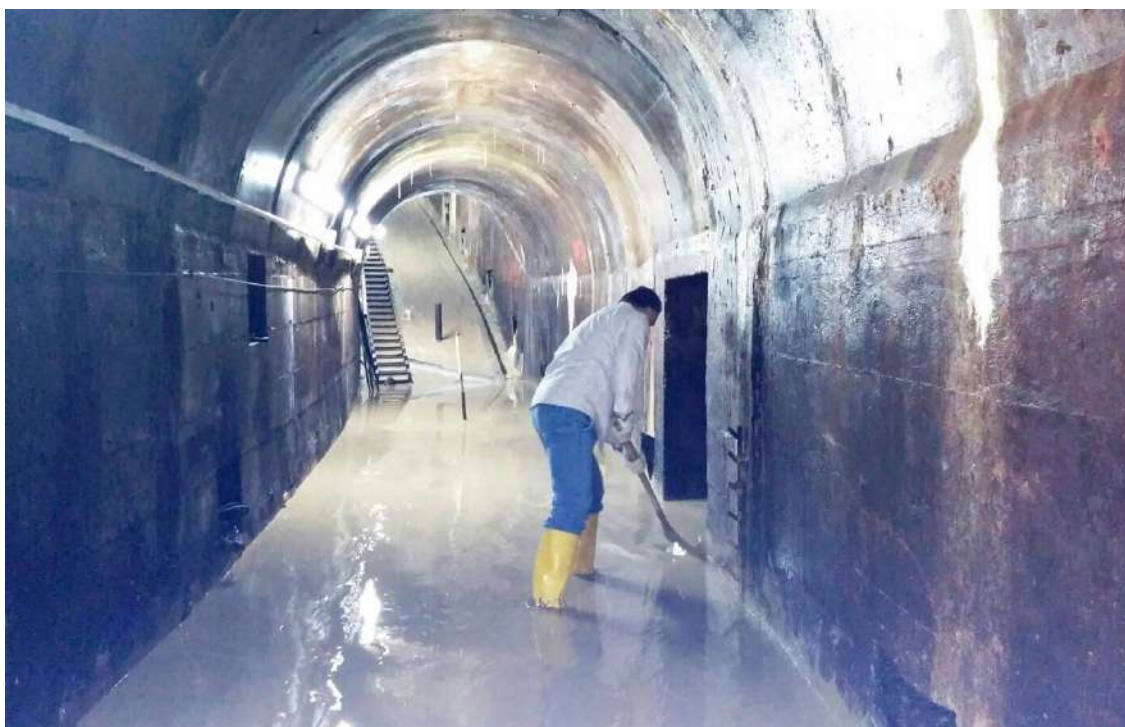
FOTO 8 - Cunicolo iniezioni in fondazione 87.20 in DX
