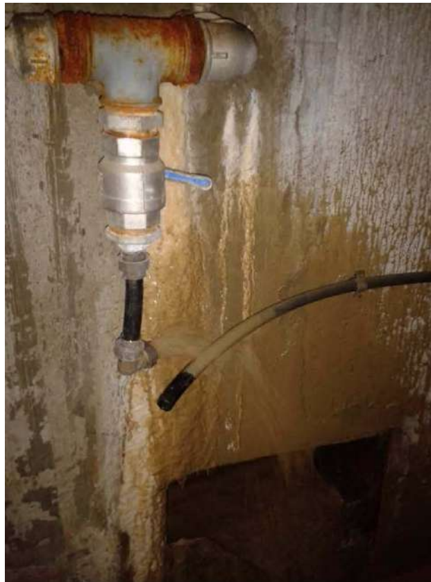
FOTO 2 - Cunicolo quota 122.50 mezzeria - camera pendolo
