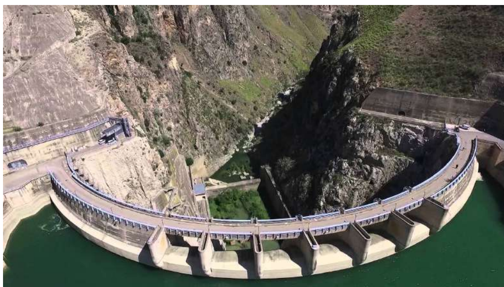
Figura 1.6 Diga Rosamarina, vista da monte sfioratore, scarico di superficie
