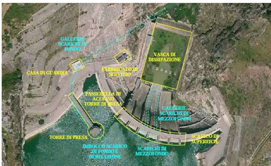
Figura 1.4 - Vista aerea dello sbarramento con indicazione opere accessorie e organi di scarico
