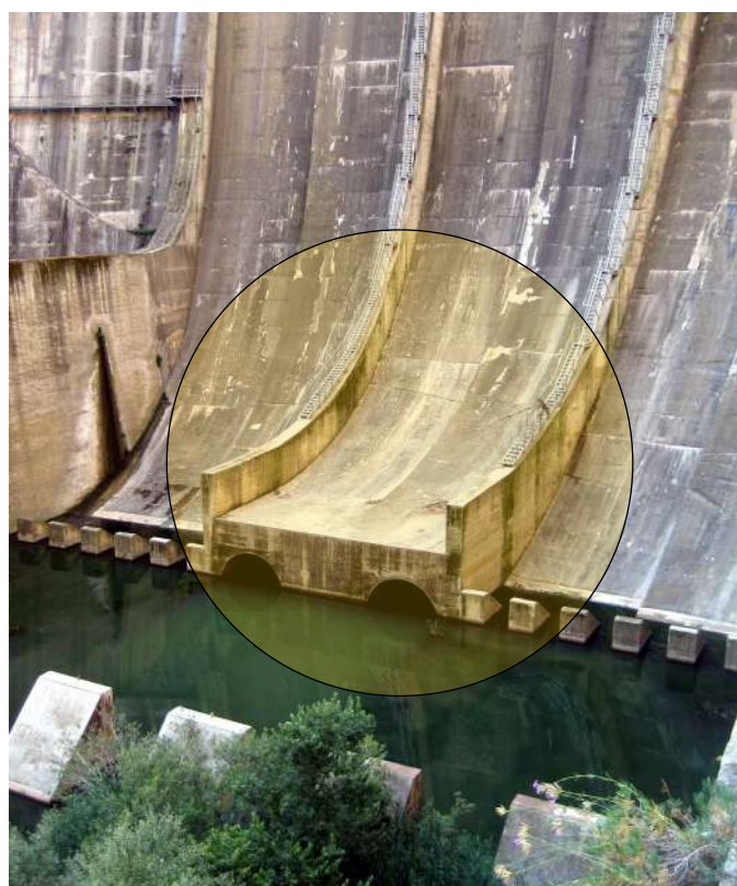
FOTO 14 - Settore dello scivolo centrale sovrastante la camera di manovra
