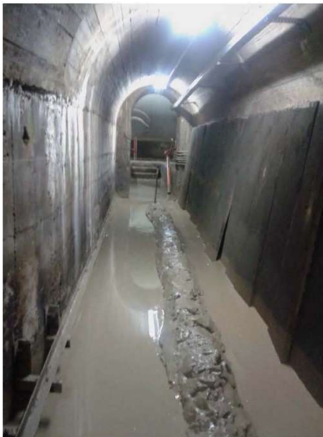
FOTO 5 – Cunicolo in fondazione accesso camera di manovra sussidiari a quota 89,40
