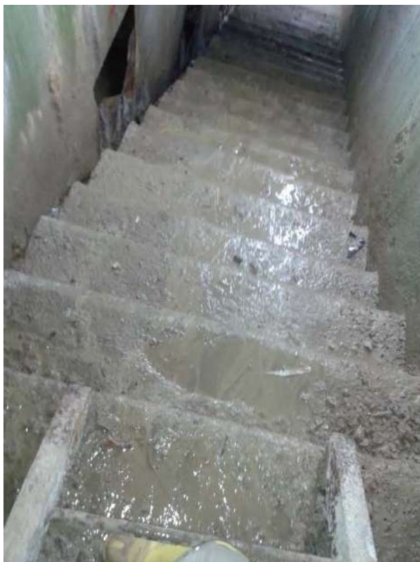
FOTO 3 - Cunicolo perimetrale SX - scala di collegamento al cunicolo a quota 122.50
