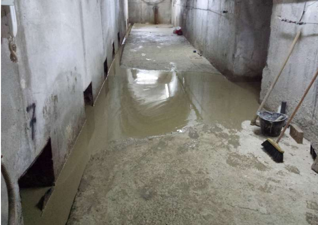
FOTO 1 - Cunicolo quota 122.50 in SX - zona accesso dalla passerella metallica
