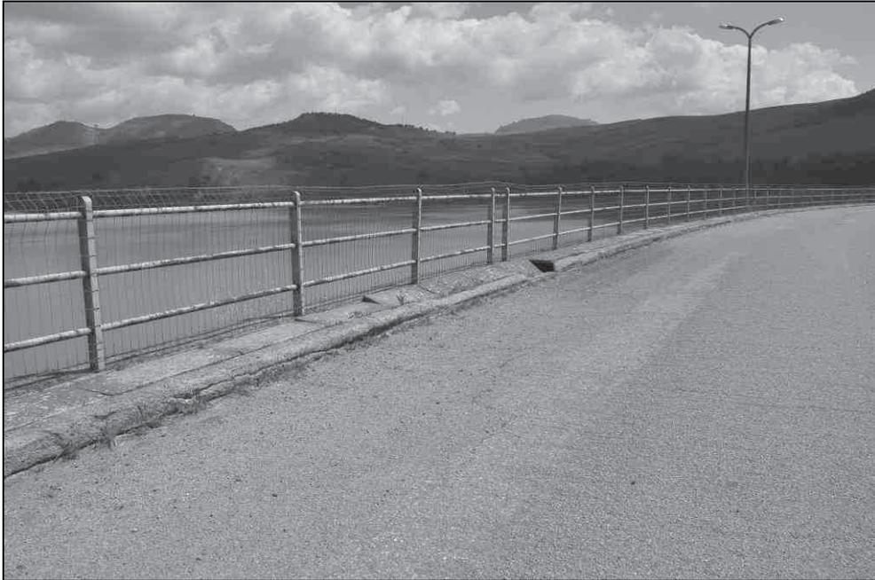
Foto 5 – Panoramica del coronamento con, in primo piano, i tegoli dissestati del cavidotto impianti
