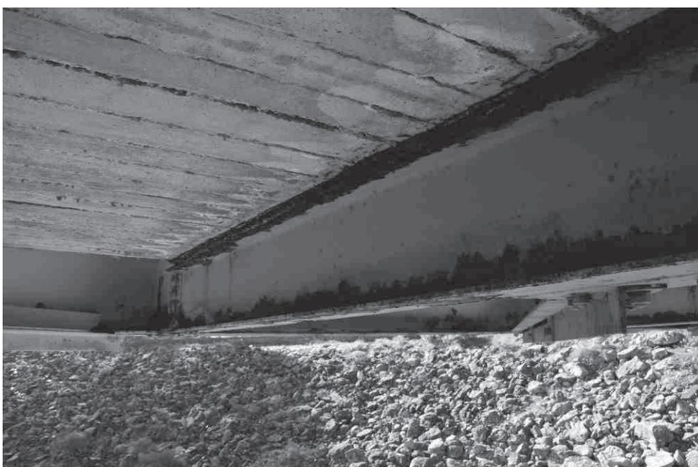
Foto 16 – Particolare delle travi di appoggio della passerella metallica
