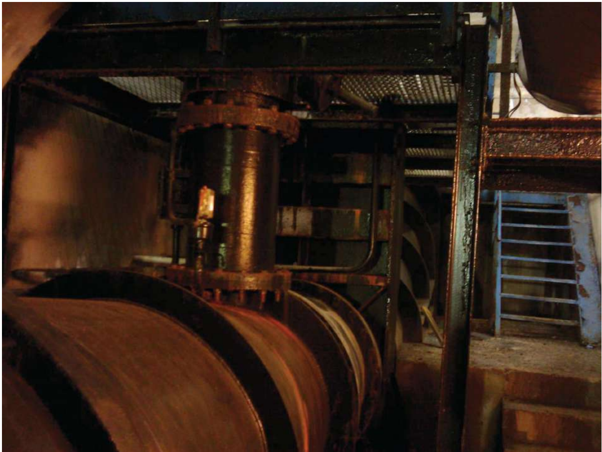
Camera di manovra interna al cunicolo di derivazione –scarico di esaurimento in corrispondenza del torrino di presa derivazione e presa scarico di esaurimento
