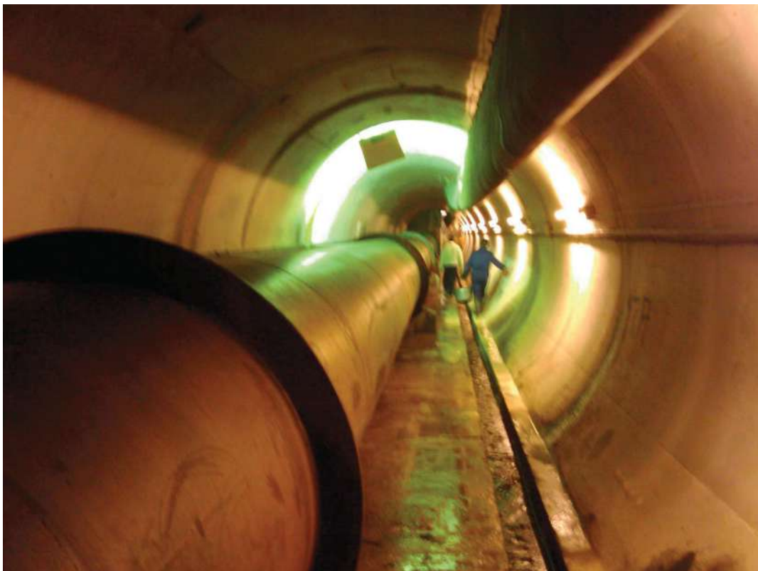
Cunicolo di derivazione –scarico di esaurimento
