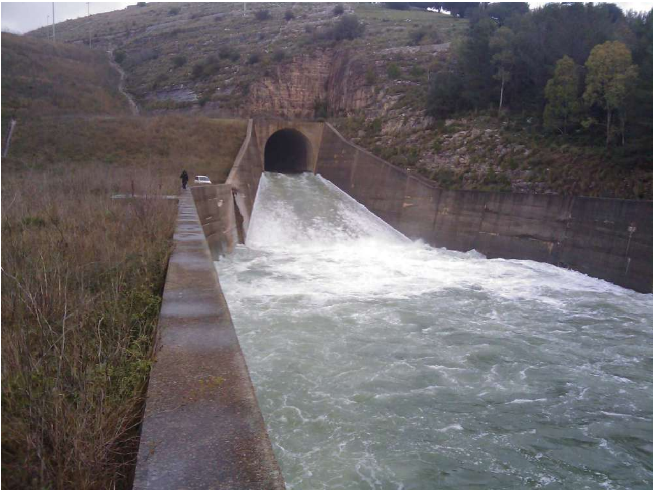
Sbocco galleria a valle dello scarico di superficie – scarico di fondo e vasca di calma
