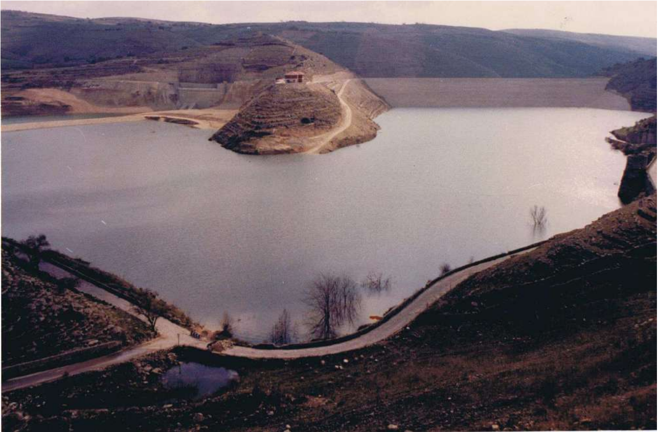
Vista d'insieme della diga Santa Rosalia ricadente nel Comune di Ragusa a seguito del completamento dei lavori di realizzazione
