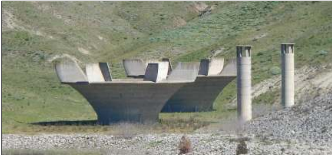
Figura 3-5: Sfiatori a calice e torrini aerofori (destra e sinistra)
