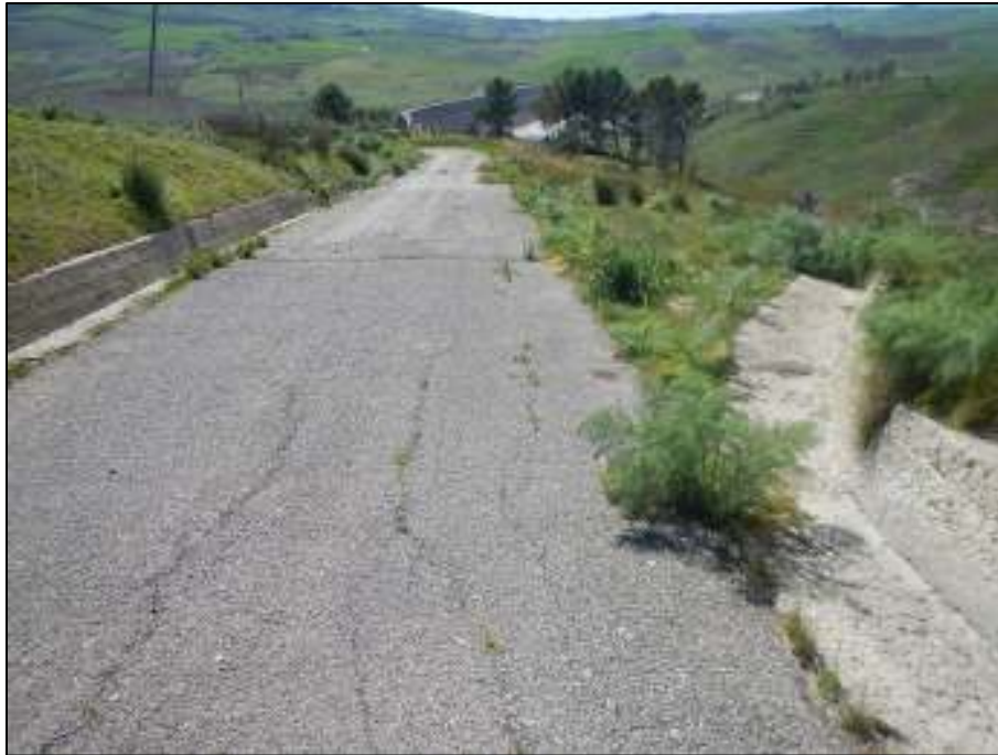
Figura 3-37: Strada di accesso al coronamento
