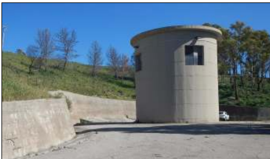
Figura 3-8: Torre paratoie scarico di fondo e derivazione
