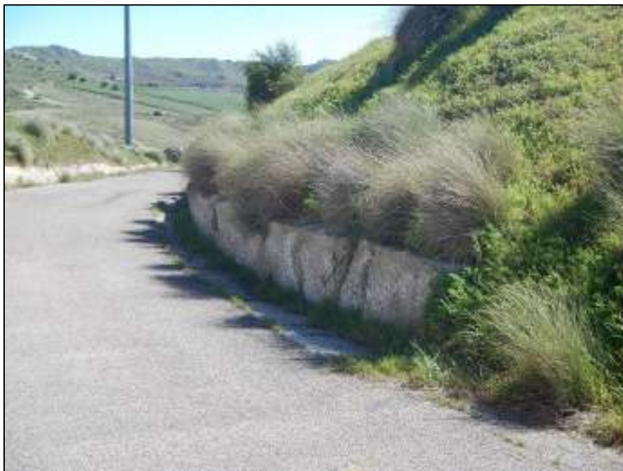
Figura 3-38: Strada di accesso al coronamento
