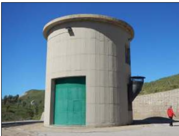
Figura 3-9: Torre paratoie scarico di fondo e derivazione
