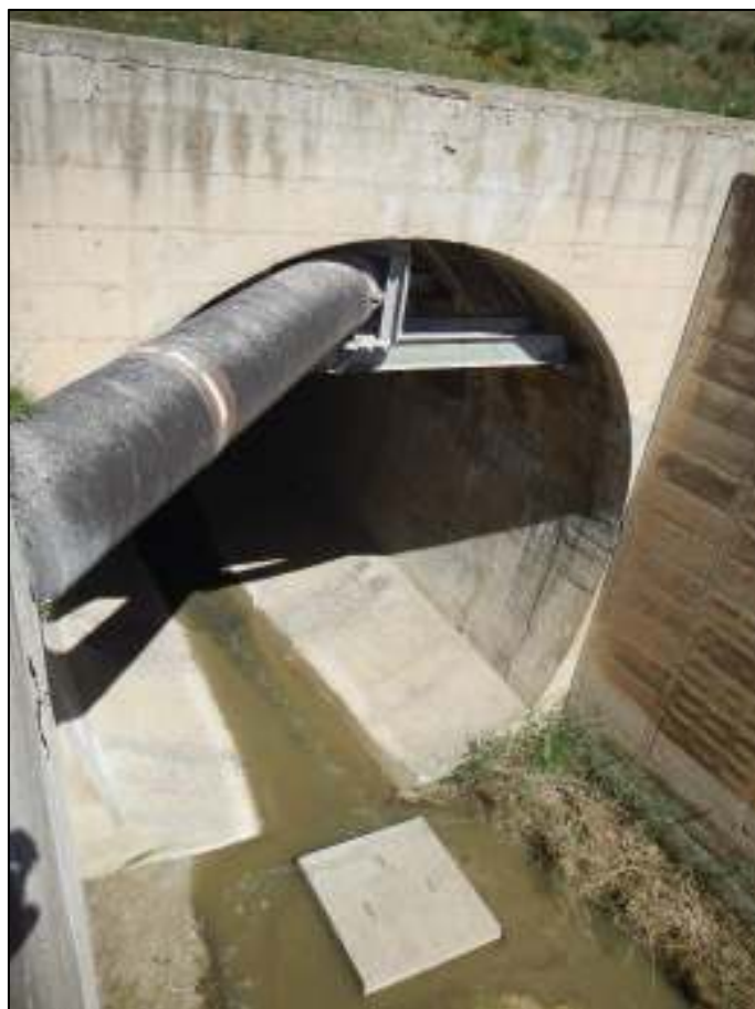
Figura 3-17: Galleria dello scarico di fondo – Vista dello sbocco nella vasca di dissipazione
