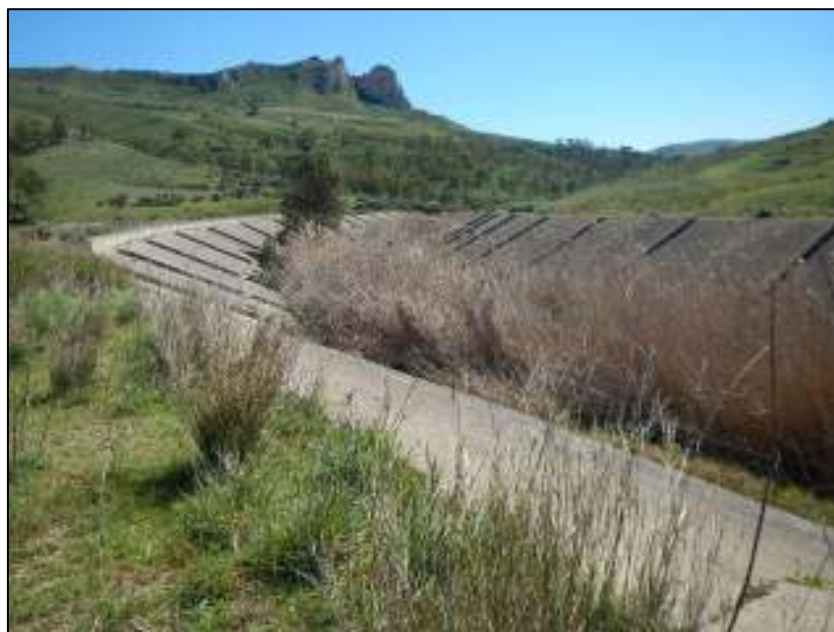
Figura 3-24: Canale di restituzione in alveo
