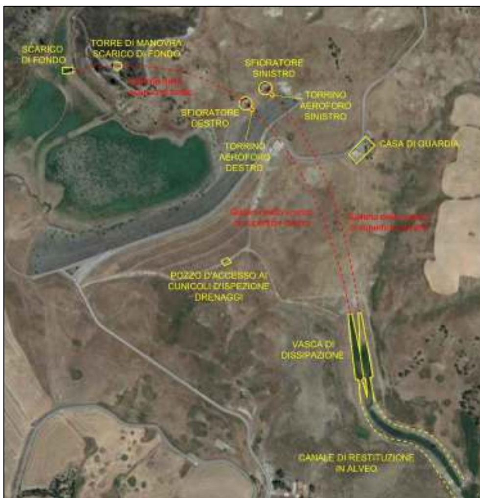
Figura 3-1: Diga Gibbesi – Vista aerea dello sbarramento con indicazione schematica di alcune delle opere accessorie oggetto di studio
