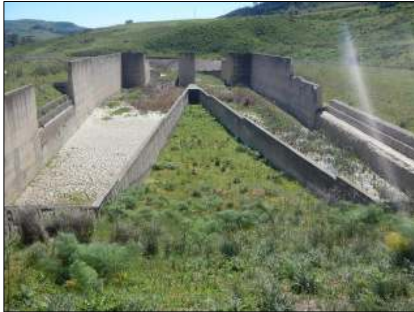
Figura 3-23: Vasca di dissipazione
