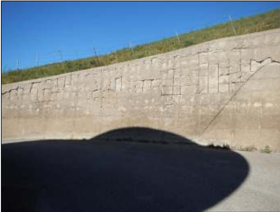
Figura 3-39: Muro di sostegno a protezione del piazzale della torre di manovra
