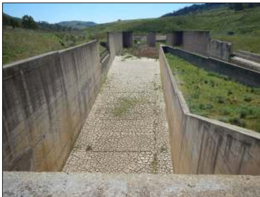
Figura 3-22: Vasca di dissipazione – Sbocco della galleria scarico di superficie sinistro
