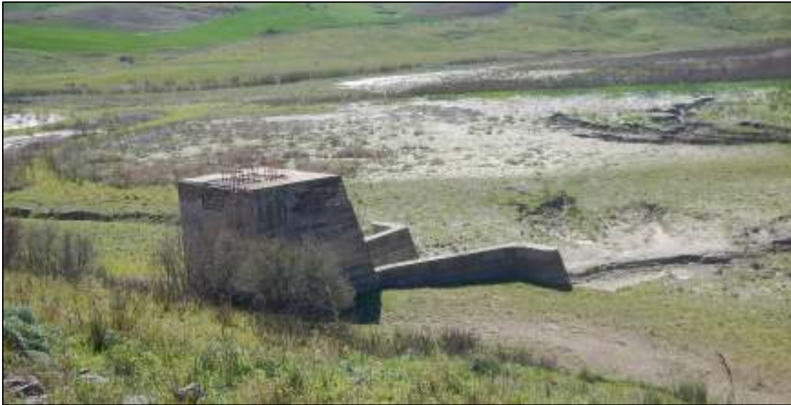
Figura 3-14: Opera di imbocco dello scarico di fondo
