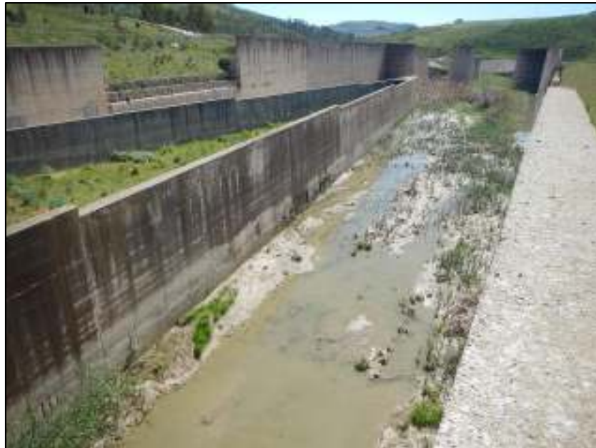
Figura 3-21: Vasca di dissipazione – Sbocco della galleria dello scarico di fondo
