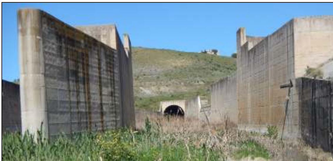
Figura 3-19: Galleria scarico di superficie sinistro – Vista dello sbocco nella vasca di dissipazione
