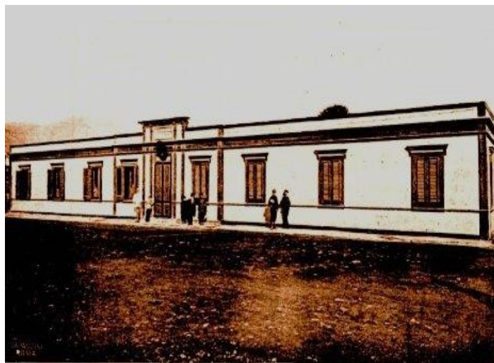
Fig.18 Messina - Ufficio del Genio Civile-Servizio Terremoto
