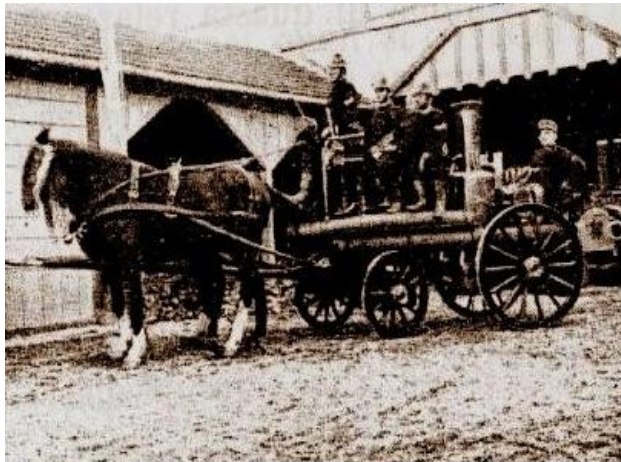
Fig. 14 -Difesa Incendi - Pompa a vapore
