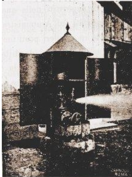
Fig. 15 Idrante a doppia presa
