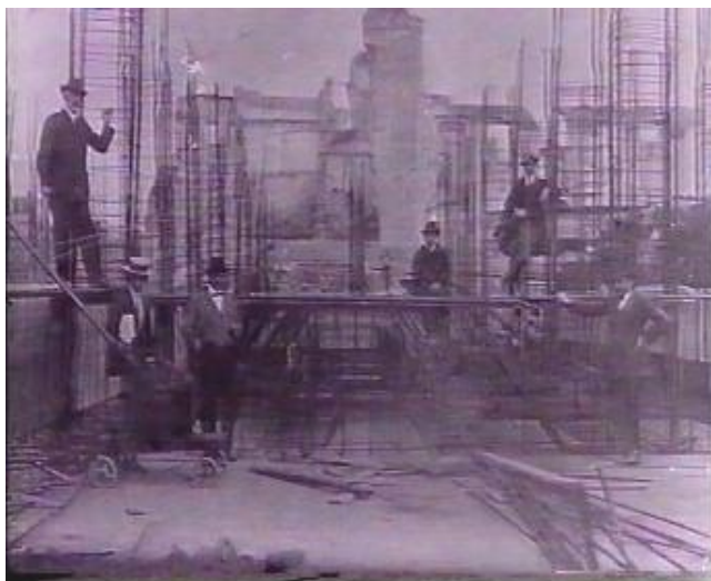
Fig. 23 -Messina - Ricostruzioni in cemento armato
