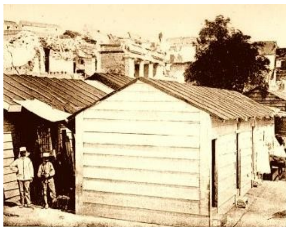
Fig.5 Messina- Baracche provvisorie costruite dal Genio Civile a Messina nei primi giorni dopo il terremoto.
