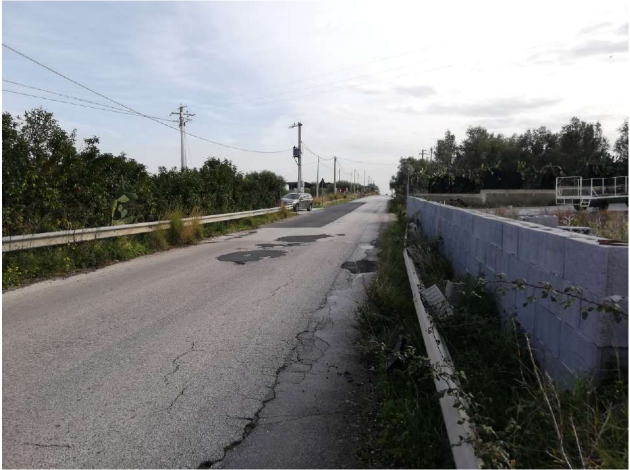
Figura 1 - Stato di fatto pavimentazione stradale (situazione diffusa)
