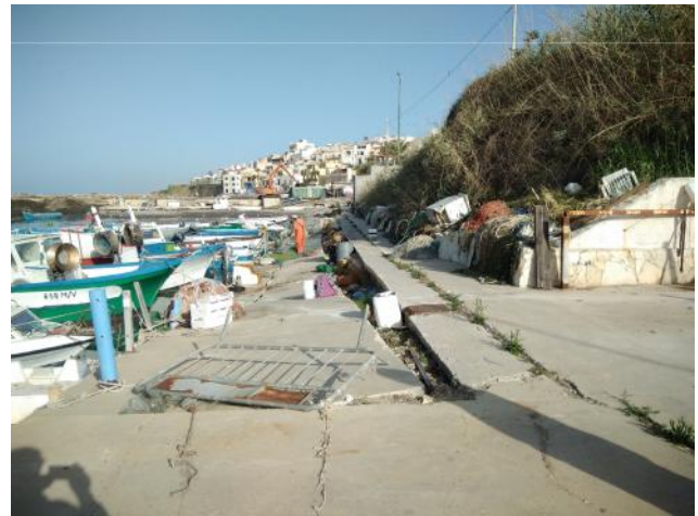
Banchina di riva crollata e accumulo di alghe fin oltre la superficie - Vista da ovest e da est
