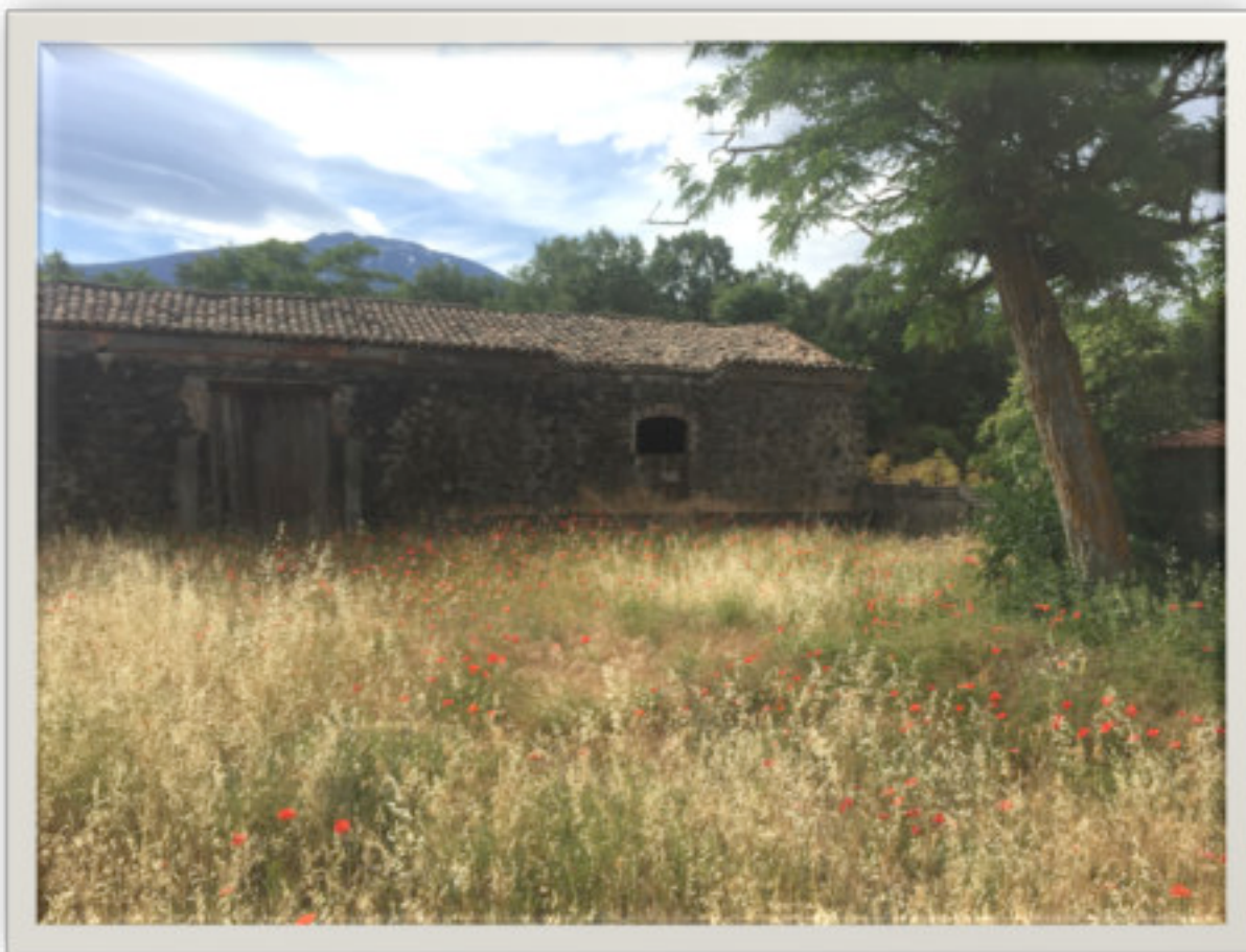
Figura 17 - Fabbricato A in proprietà Saitta
