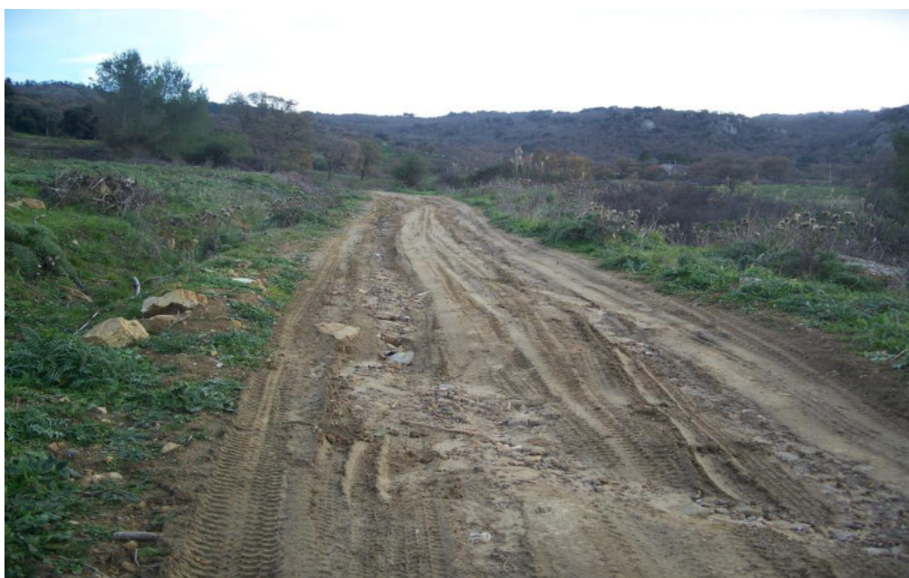
Un tratto della viabilità principale che conduce ai fabbricati.
