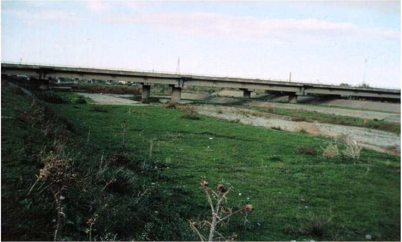
Figura 8 - Fiumara di Niceto presso l'attraversamento autostradale Palermo-Messina (A20).
