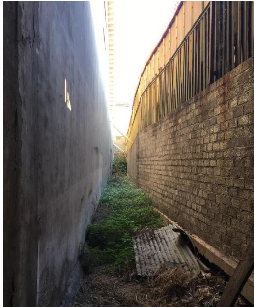
Fig. 6 – Muro d'argine in sponda sinistra tra le sezioni 11 e 10
