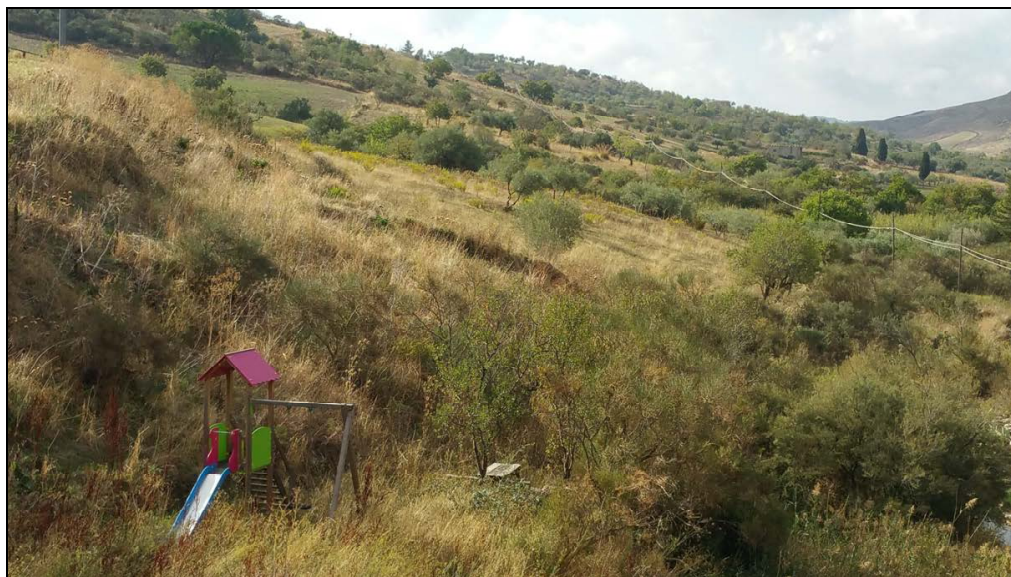
Foto n. 6 – dissesto 072-6PE-151 (Versante del Fiume Imera Meridionale ove è ubicato il Giardino della Memoria con evidente il dissesto)
