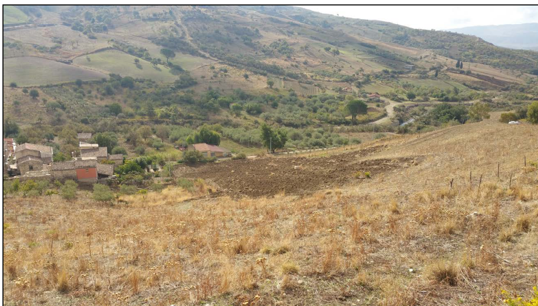
Foto n. 3 – dissesto 072-6PE-128 (Versante a monte della frazione di Raffo e dell'area in cui sono stati realizzati i drenaggi delle acque)
