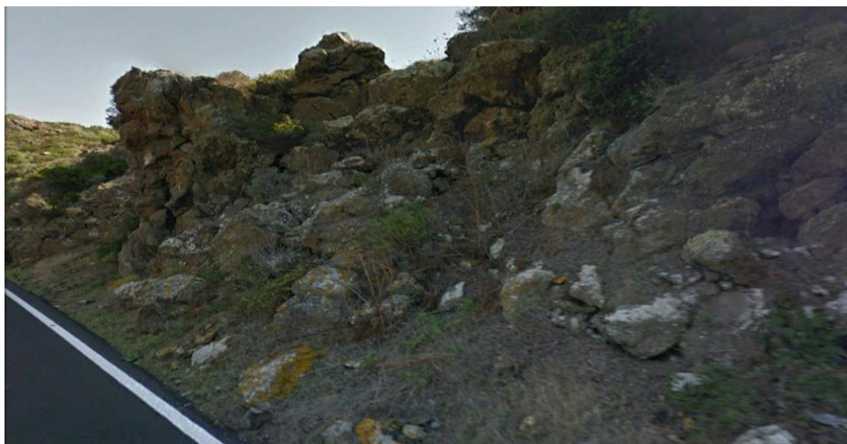
Il dissesto di crollo 106-9PN- 050 di C.da Khaggiar
