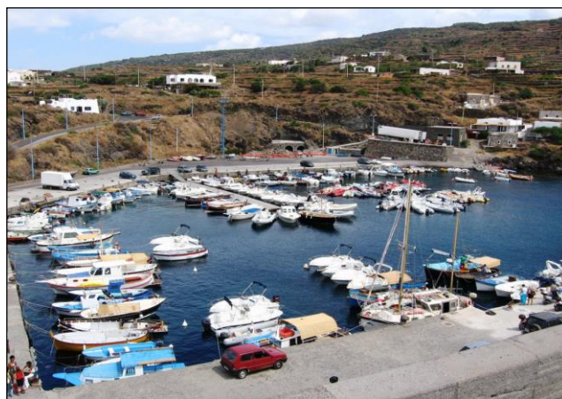
Il dissesto 106-9PN-190 strada di accesso al porto
