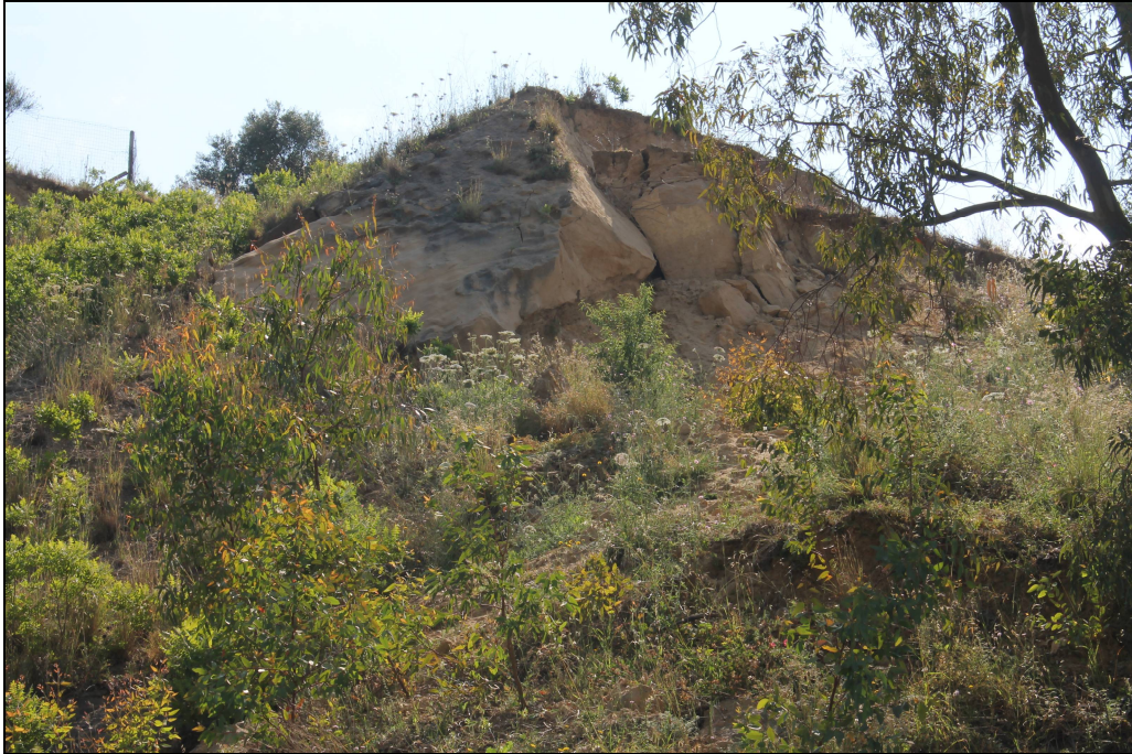
Foto n. 2 – dissesto 045-9AL-021 (S.S. n. 113 Km 332+700)
