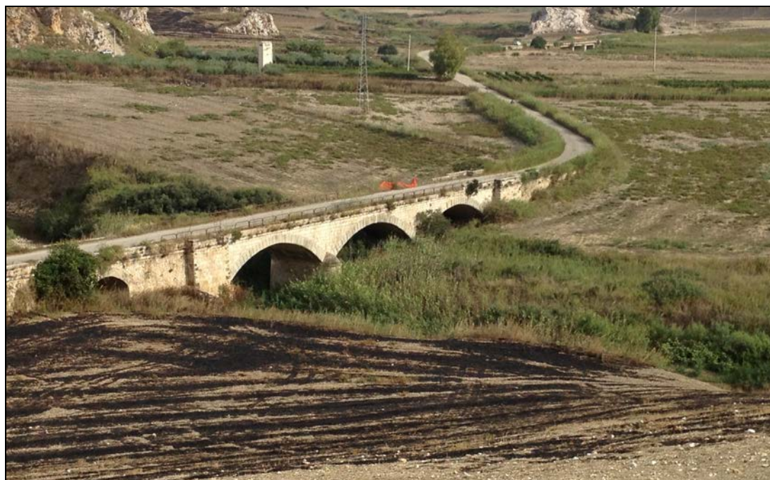
Foto n° 1 – Ponte della S.P. n° 23 sul Fiume Gallo D'Oro.
