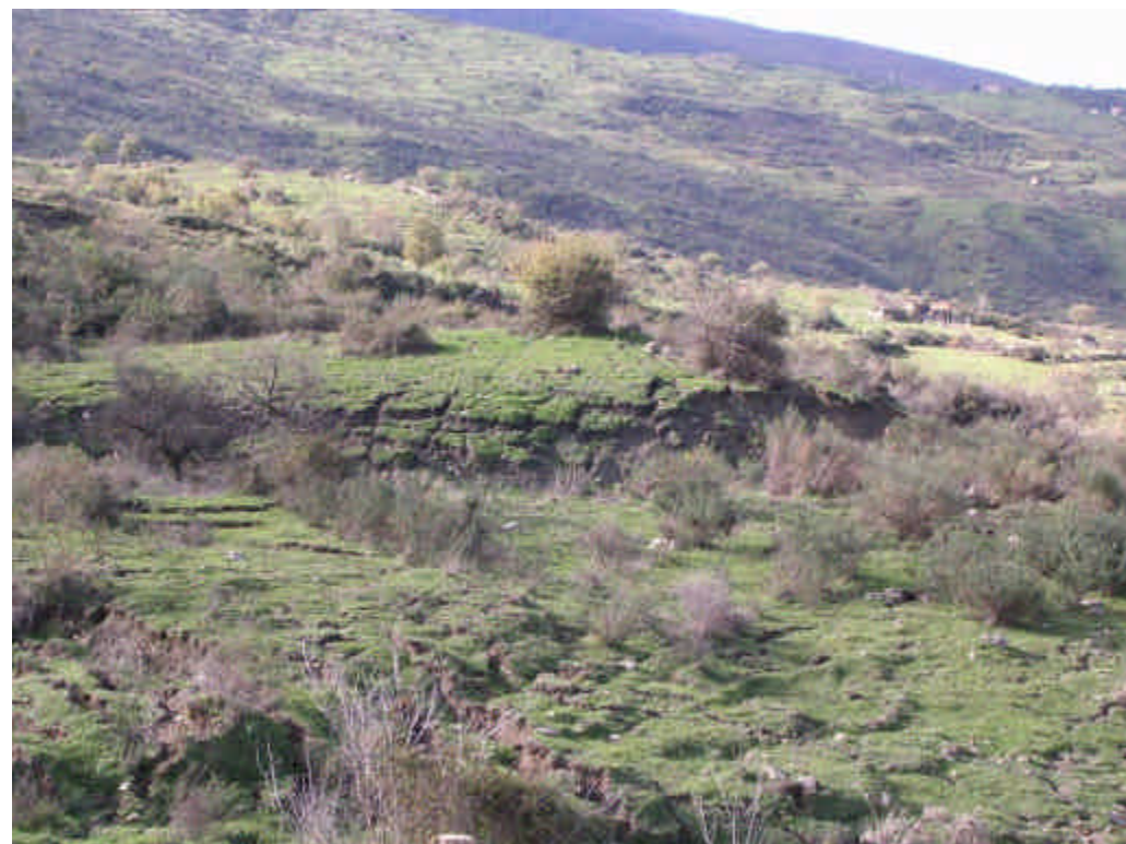
FOTO 5 (Frana di Piano Arzano): rigonfiamenti nel corpo di frana
