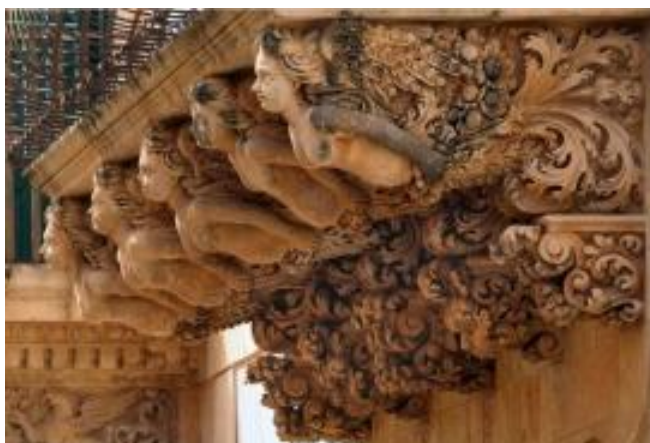
Particolare balcone barocco (www.cotidianul.ro)
