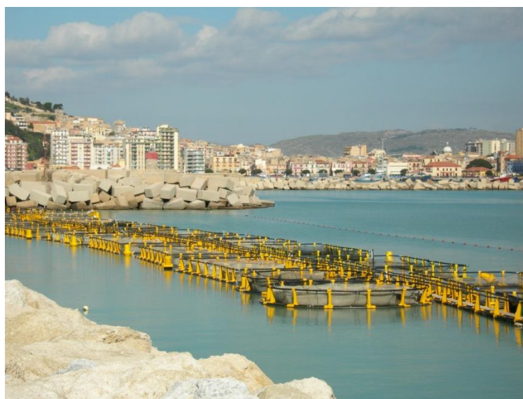
Figura 11 – Impianto di allevamento localizzato all'interno della diga foranea del Porto di Licata, costituito da gabbie di diversa tipologia realizzate con tubi in pvc e candelieri in plastica.
