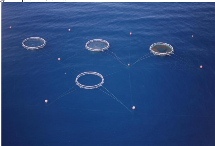
Figura 10 – Immagine aerea di un'installazione con 5 gabbie galleggianti ancorate ad un reticolo costituito da cime, boe, ancore e corpi morti, realizzata presso uno degli impianti operanti in Sicilia.
