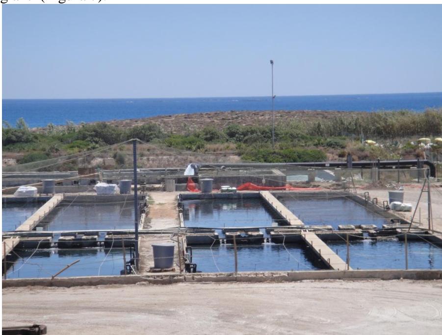
Figura 7 – Vasche di allevamento in cemento armato. Sullo sfondo si intravedono le gabbie galleggianti gestite dalla medesima Società.
