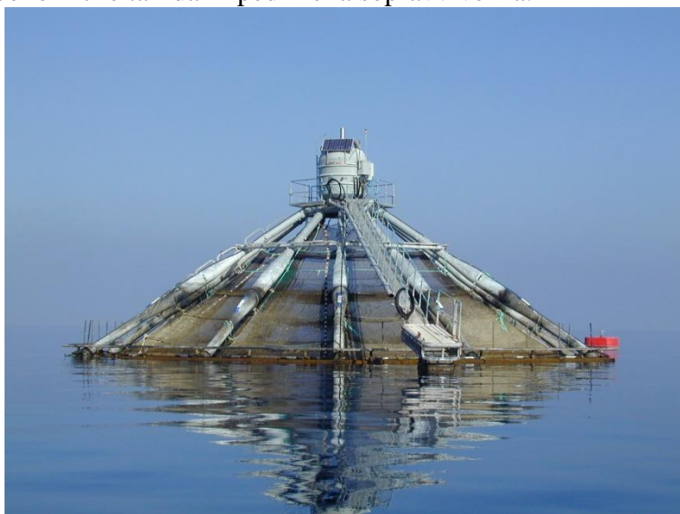
Figura 9 – Gabbia di Allevamento, tipo Farm Ocean, semisommergibile realizzata in metallo, installata in uno degli impianti siciliani.
