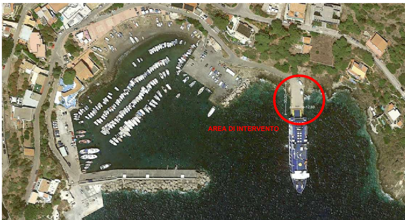
Figura 9 – Foto aerea estratta da Google Earth
