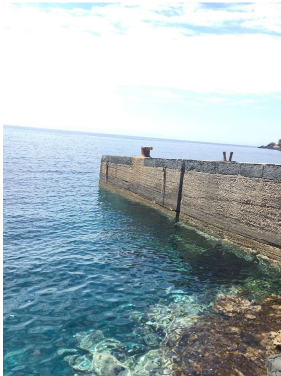
Figura 12 – Vista del molo lato mare
