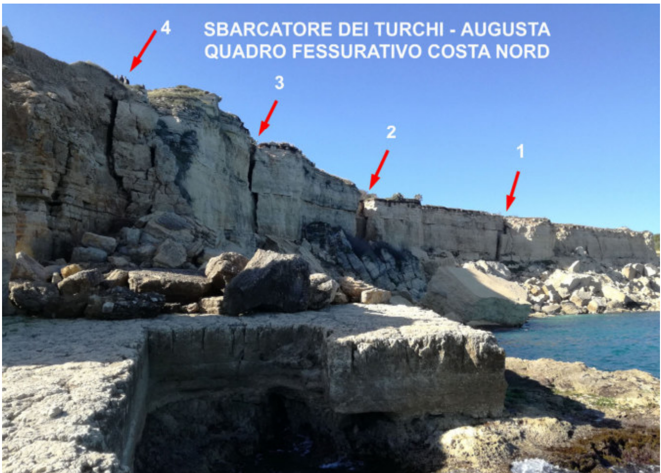
FOTO 27 – COSTA NORD FRATTURAZIONI DELLA FOTO 26 VISTE DAL CAPO
